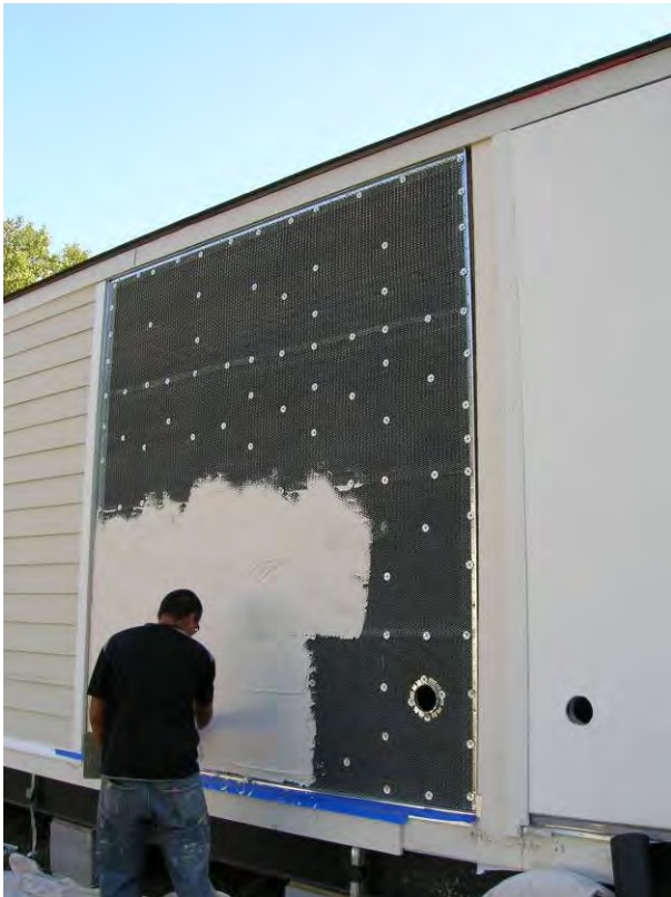
Stucco Scratch Coat
